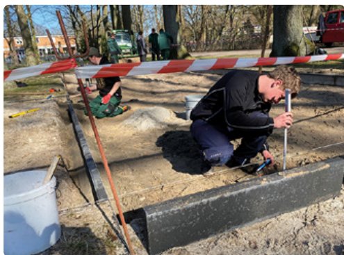
Präzisionsarbeit beim Setzen der Randsteine
